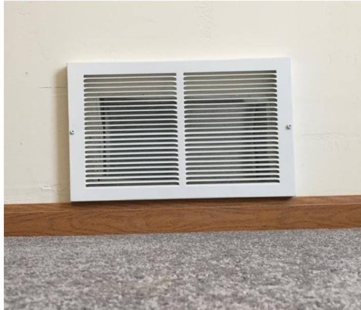
**Figure 19-8. Positioning of Cold Air Returns.**
